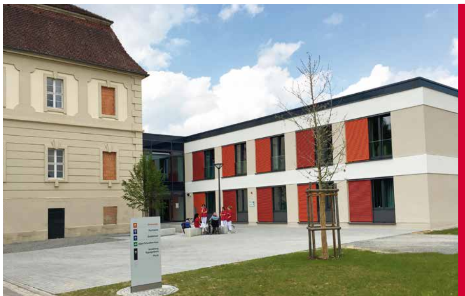
Ein verglaster, zweigeschossiger Baukörper, in dem sich der Hauptzugang zum Albert-Schweitzer-Haus befindet, verbindet den Neubau mit dem Altbau (ganz links) und schafft zugleich eine optische Trennung zwischen den beiden Gebäudetrakten.
